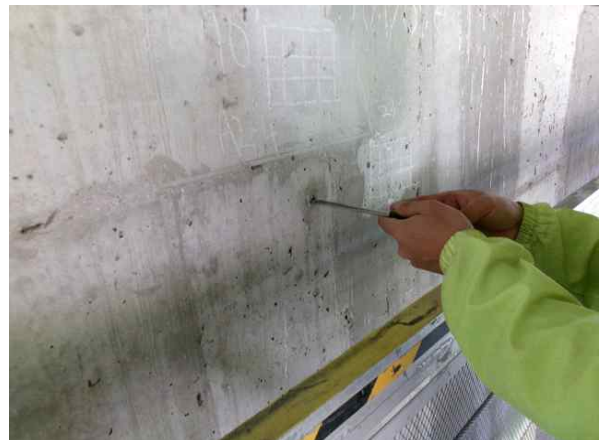
탄산화깊이 측정 현황
